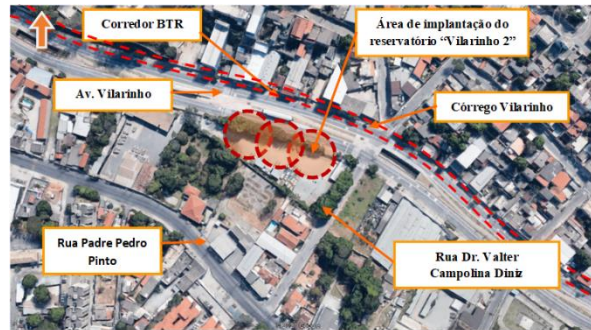
Figura 2. Vista aérea do local de intervenção – Reservatório “Vilarinho 2” (imagem retirada do Google Earth, consultada a julho de 2021).
