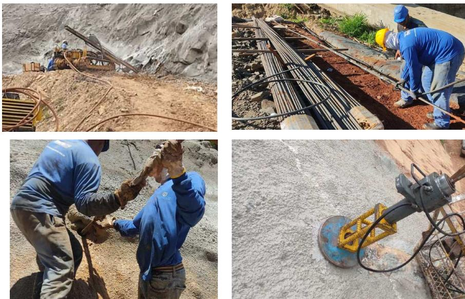
Figura 3. Execução do ensaio de arrancamento.
