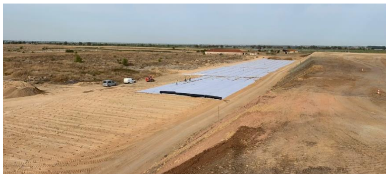
Figura 5. Aplicação do geocompósito drenante na base do aterro de pré-carga.
