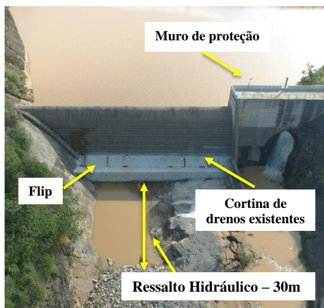
Figura 8. Adequação das estruturas.
