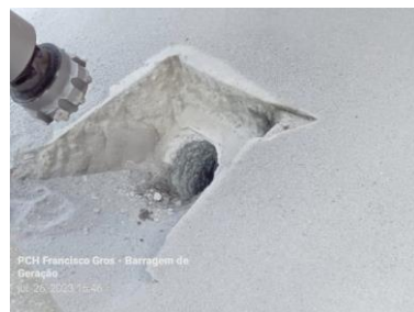
Figura 11. Perfuração em concreto e rocha para os tirantes
