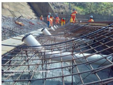
Figura 10. Concretagem da laje e flip
