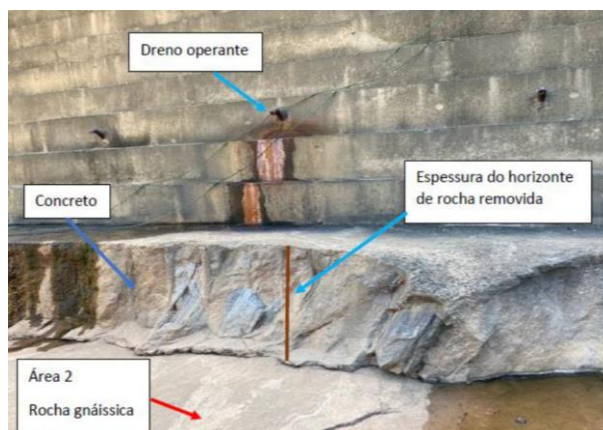
Figura 3. Detalhe para horizonte de espessura de rocha removida no pé da barragem.
