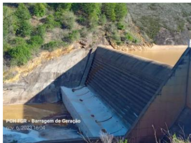
Figura 12. Reforço estrutural do vertedouro
