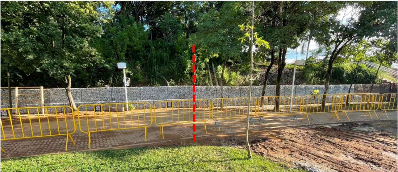
Figura 8. Muro de gabião experimental, trecho a esquerda em gabião de malha soldada e trecho a direita em gabião de malha tecida.
