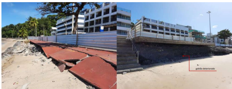
Figura 1. Condição das estruturas existentes, fonte: SEINFRA
