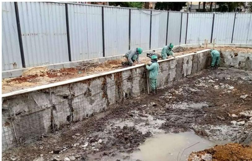
Figura 5. Início das escavações para o solo grampeado
