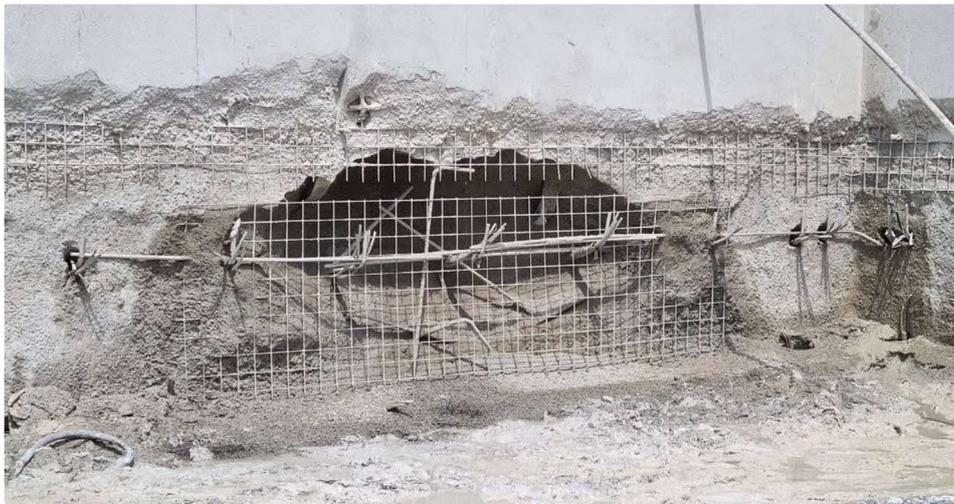
Figura 7. Trecho já com a tela metálica instalada
