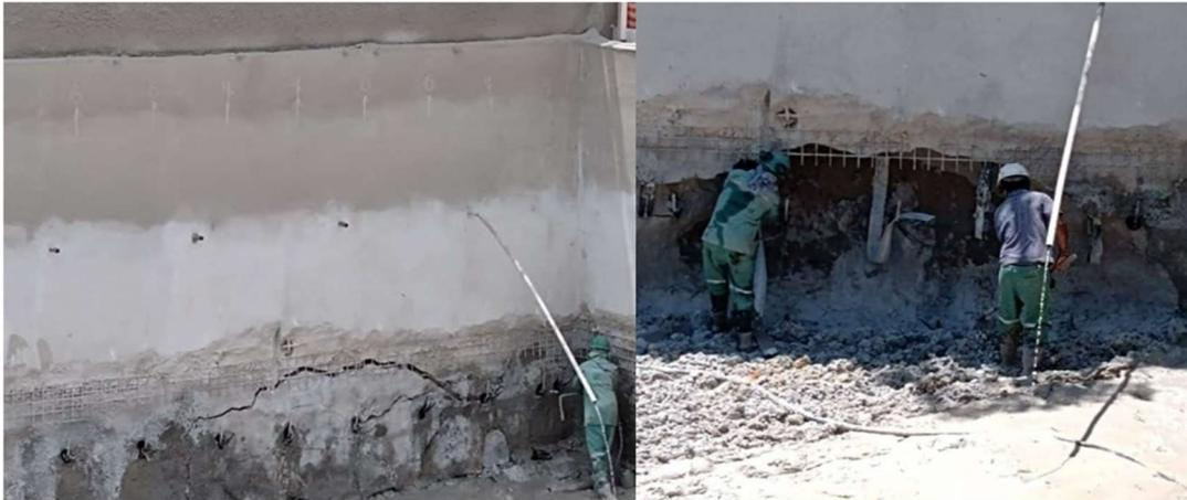
Figura 6. Trinca onde ocorrerá deslocamento e talude após a ocorrência
