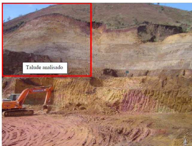
Figura 3. Registro fotográfico de 2008 – terraplenagem em andamento
