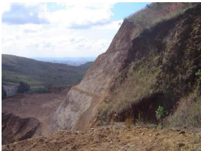
Figura 4. Registro fotográfico de 2008 – terraplenagem em andamento
