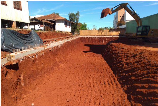
Figura 4. Detalhe das escavações das estacas e seus espaçamentos. Fonte: Camerini e Serraglio (2022).
