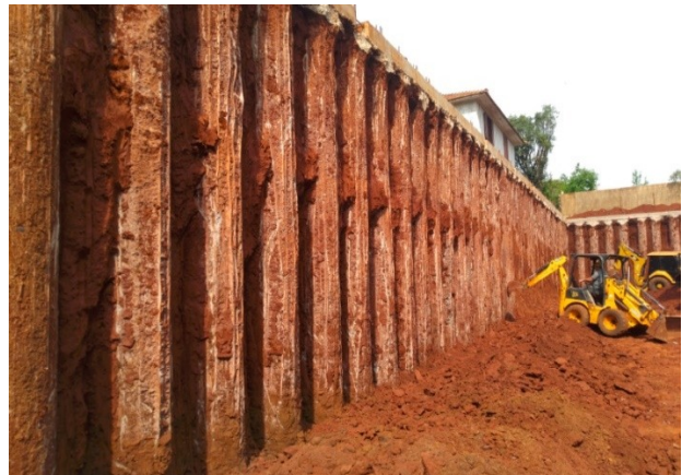
Figura 5. Detalhes da escavação dos cachimbos, avanço das escavações e liberação total do comprimento livre das estacas sobre esforços. Fonte: Camerini e Serraglio (2022).
