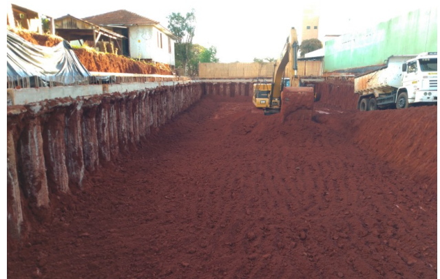
Figura 4. Detalhe das escavações das estacas e seus espaçamentos. Fonte: Camerini e Serraglio (2022).
