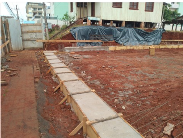
Figura 3. Detalhe da viga de coroamento da cortina e esperas superiores antes das escavações. Fonte: Camerini e Serraglio (2022).
