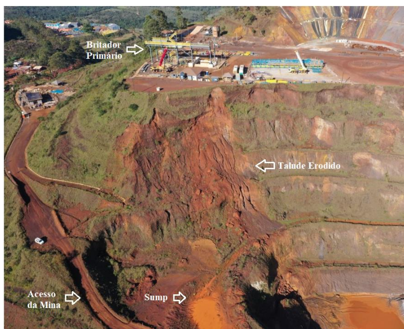
Figura 1. Localização do Talude Erodido.
