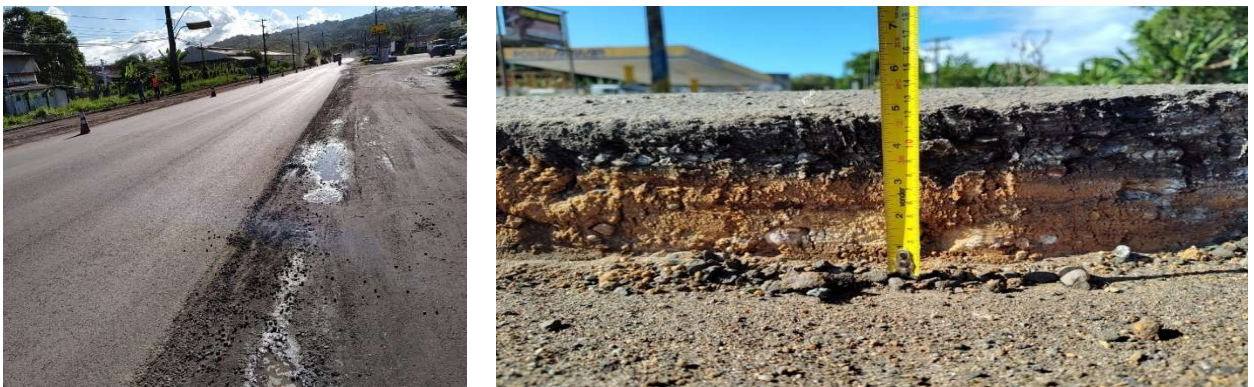
Figura 2. Restauração realizada em 2023 e espessura adotada
