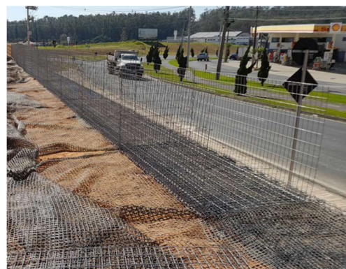
Figura 10. Montagem do gabião com geogrelha Fonte: De autoria própria
