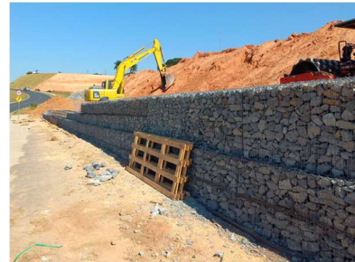
Figura 15. 1 Compactação do aterro Fonte: De autoria própria
