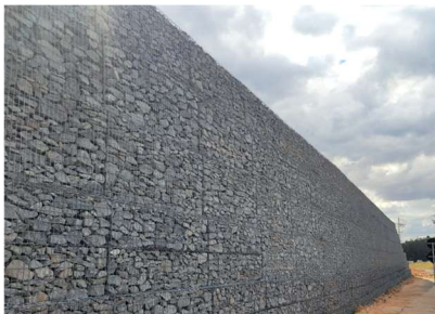
Figura 14. Face do Muro Fonte: De autoria própria
