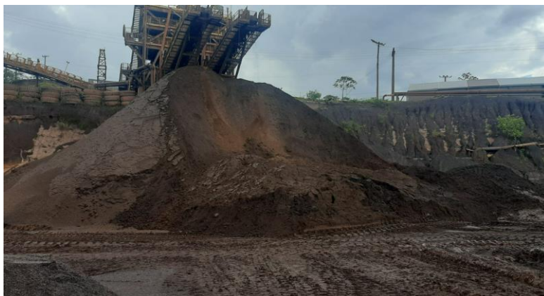
Figura 2. Imagem da pilha após o deslizamento de material (Fonte: Autor, 2022).
