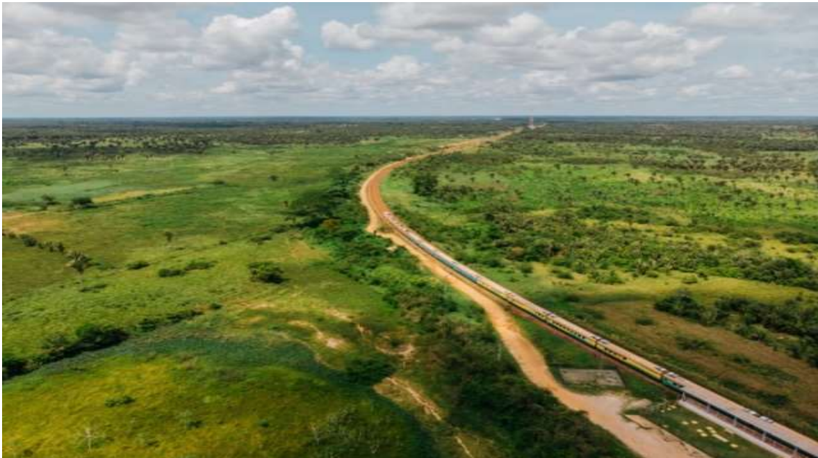
Figura 1: Vista geral da linha férrea EFC
