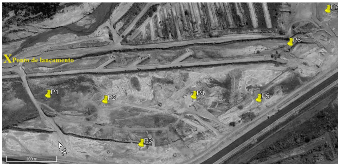
Figura 1. Pontos dos ensaios CPTu na barragem.
