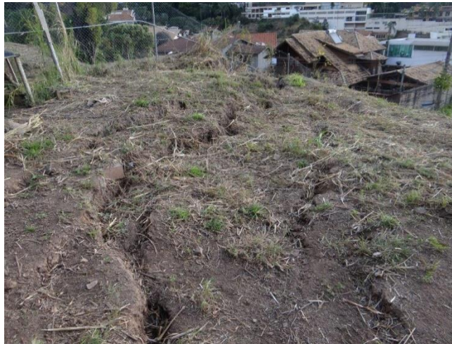
Figura 8. Trinca transversal no terreno. (O autor, Julho/2018).
