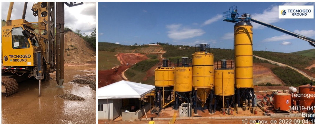
Figura 4 - Exemplo de equipamento - Vibrocat e central de mistura e injeção.
