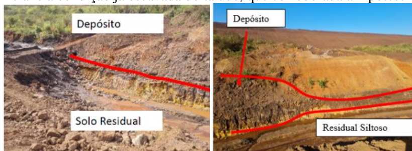
Figura 2: Fotografias dos materiais na visita inicial e na fase de escavação, validando os materiais previstos.
