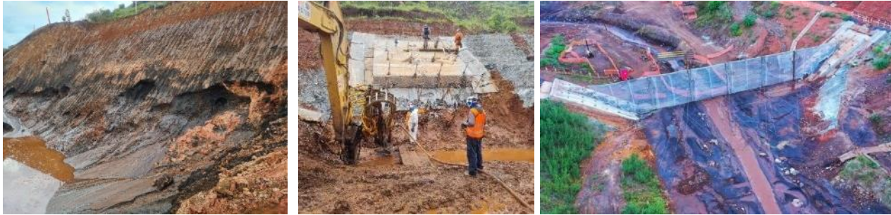
Figura 9: Fotografias das (a) instabilidades no talude, (b) uma das cortinas em execução e (c) da malha 03 concluída.
