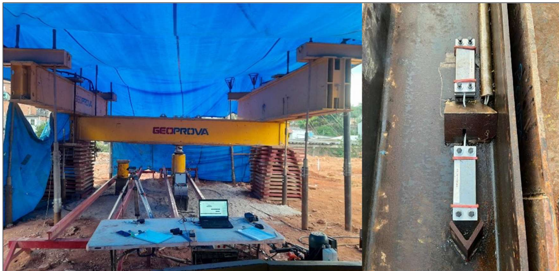
Figura 4. A esquerda: montagem da prova de carga utilizando reações no sistema SAP. A direita foto dos sensores resistivos ( strain gages ) utilizados.
