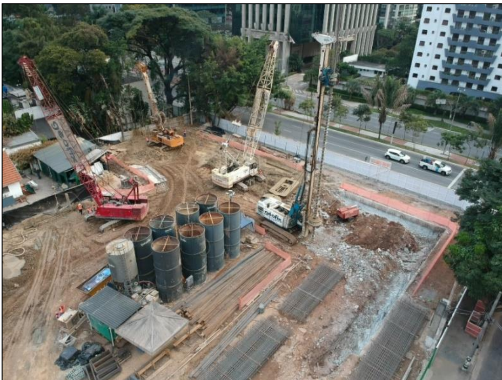
Figura 5. Canteiro de obra durante a escavação de parede diafragma.
