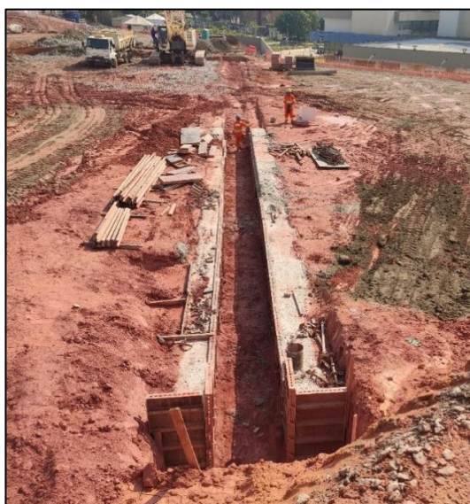
Figura 2. Execução de mureta-guia.
