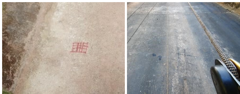
Figura 4. Execução do teste esclerométrico nas estruturas do vertedouro.
