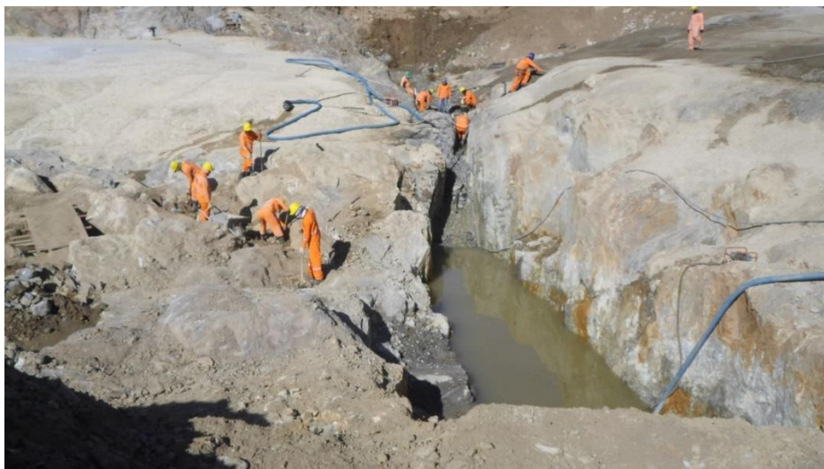
Figura 4. Vista da cava proveniente do fraturamento da rocha durante bombeamento (SOHIDRA, 2016).
