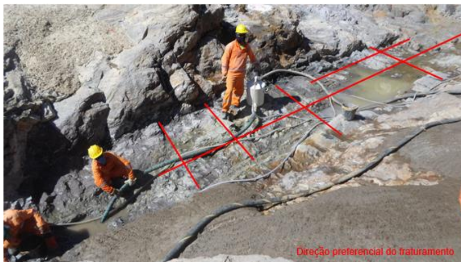
Figura 3. Direções preferenciais de fraturamento da rocha de fundação (SOHIDRA, 2016).
