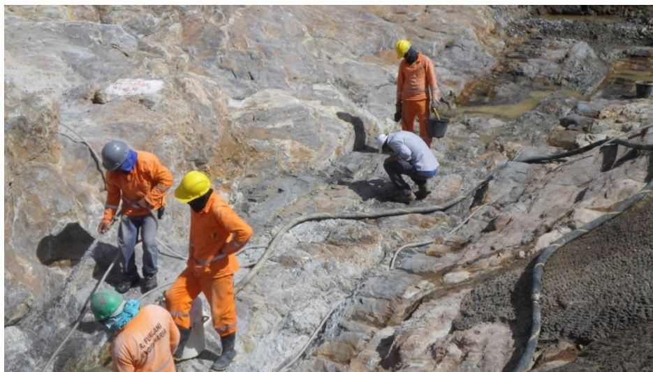
Figura 5. Execução do preenchimento da fratura com concreto de regularização (SOHIDRA, 2016).
