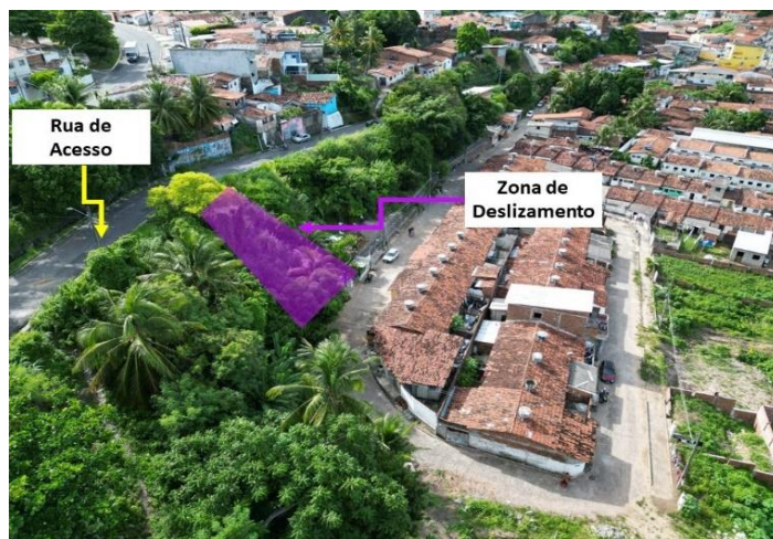
Figura 4. Levantamento de drone na via de acesso principal ao Baixo Roger.
