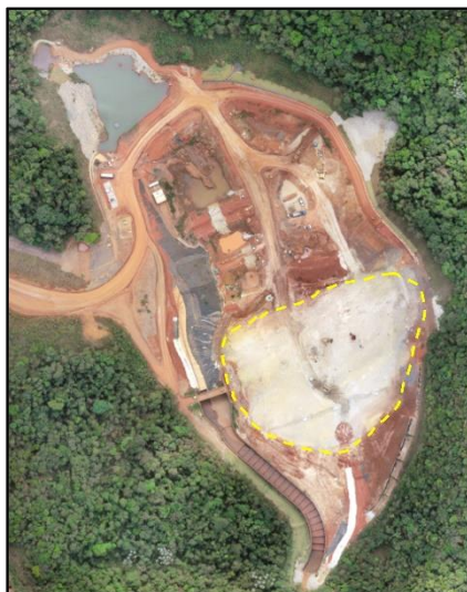
Figura 1. Vista aérea da fundação com exposição do saprólito de filito, e com detalhe tracejado em amarelo indicando a área de tratamento.
