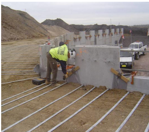
Figura 5 – Muro com Fitas em Aço
