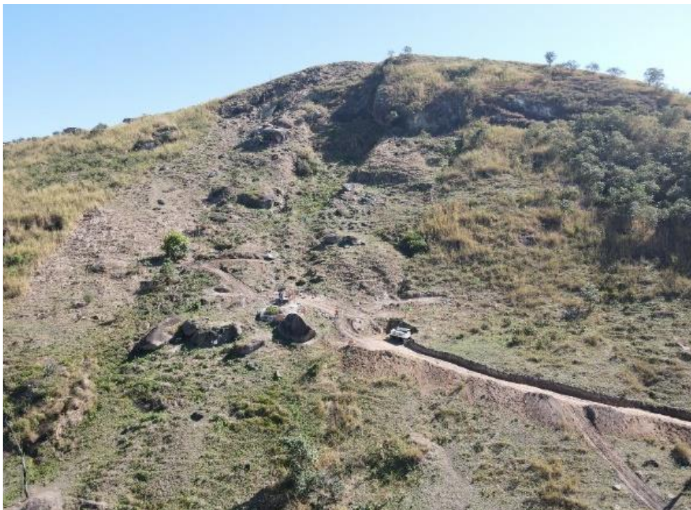
Figura 9. Preparação da área para execução das soluções.
