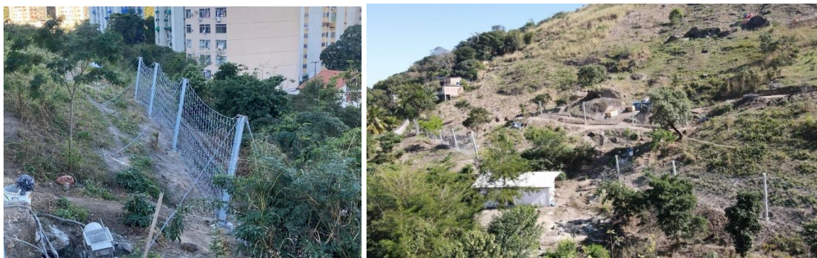
Figura 10. Obra finalizada - Barreira Dinâmica RB200.
