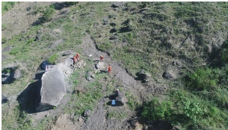
Figura 7. Desmonte de blocos.
