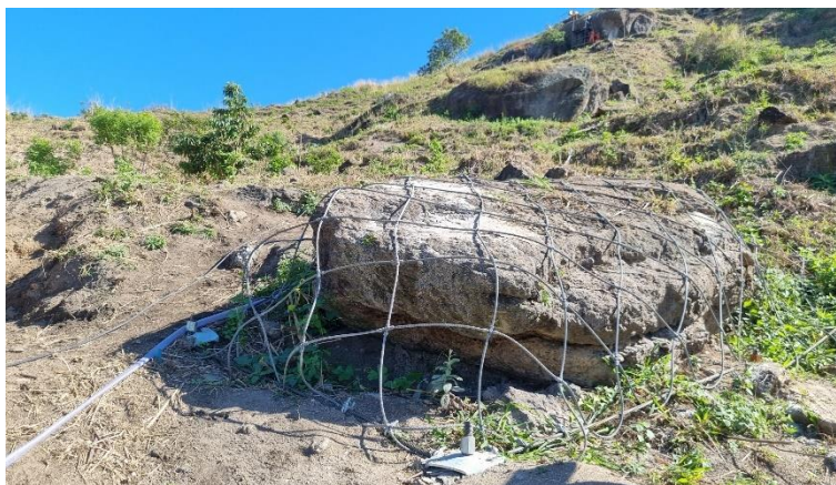
Figura 5. Envelopamento com sistema HEA Panel.
