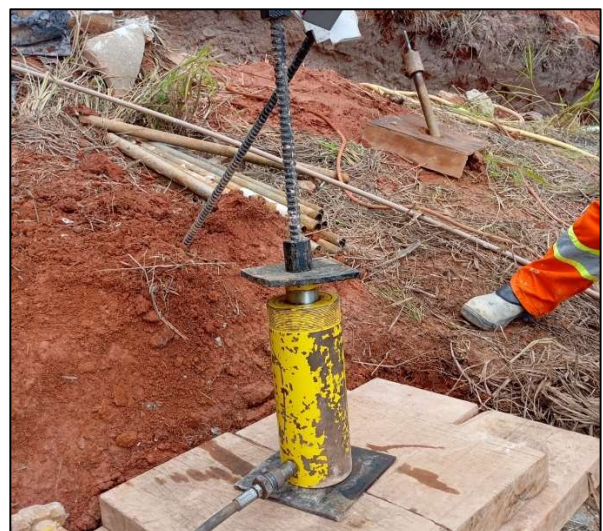
(b) Execução de ensaio de arrancamento.
