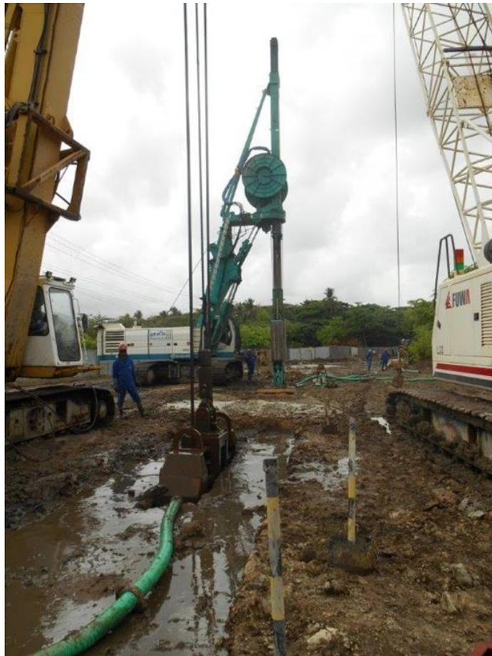
Figura 8. Execução da escavação da parede diafragma plástica
