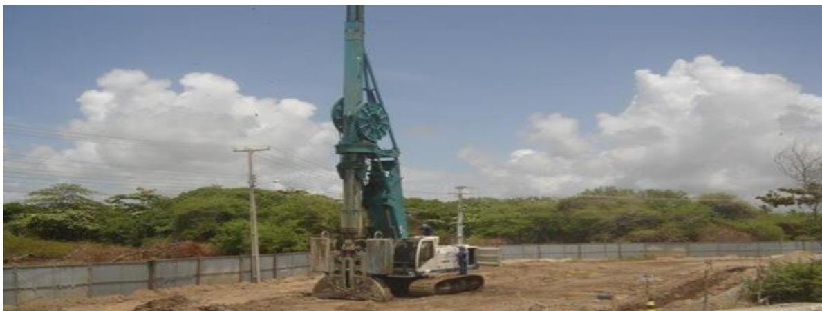
Figura 7. Diafragmadora hidráulica no local da obra.
