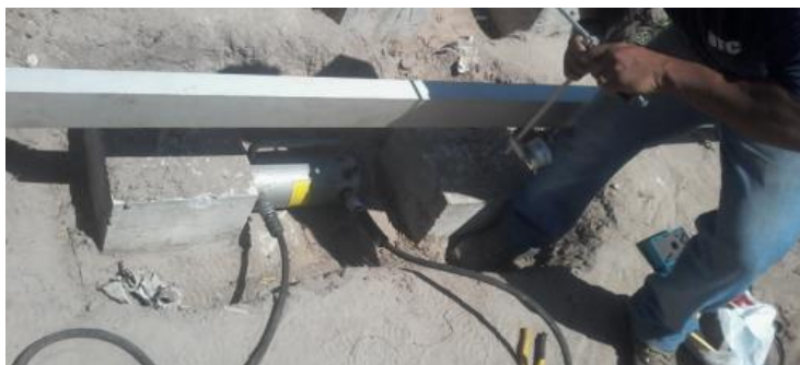
Figura 2. Montagem dos equipamentos para execução da prova de carga horizontal.
