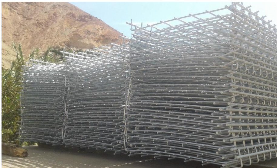
Figura 6. Painéis metálicos eletrossoldados galvanizados do paramento frontal da contenção. FONTE: Freyssinet Terra Armada Perú S.A.C.
