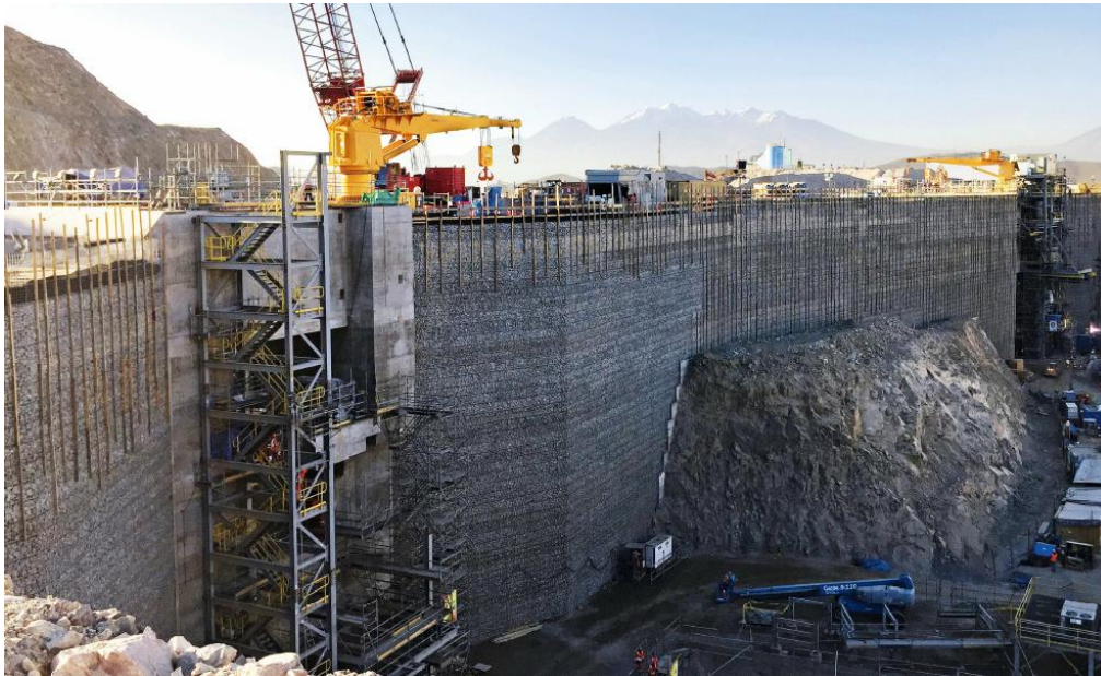
Figura 12. Muro de contenção em reforçado finalizado. FONTE: Freyssinet Tierra Armada Perú S.A.C.
