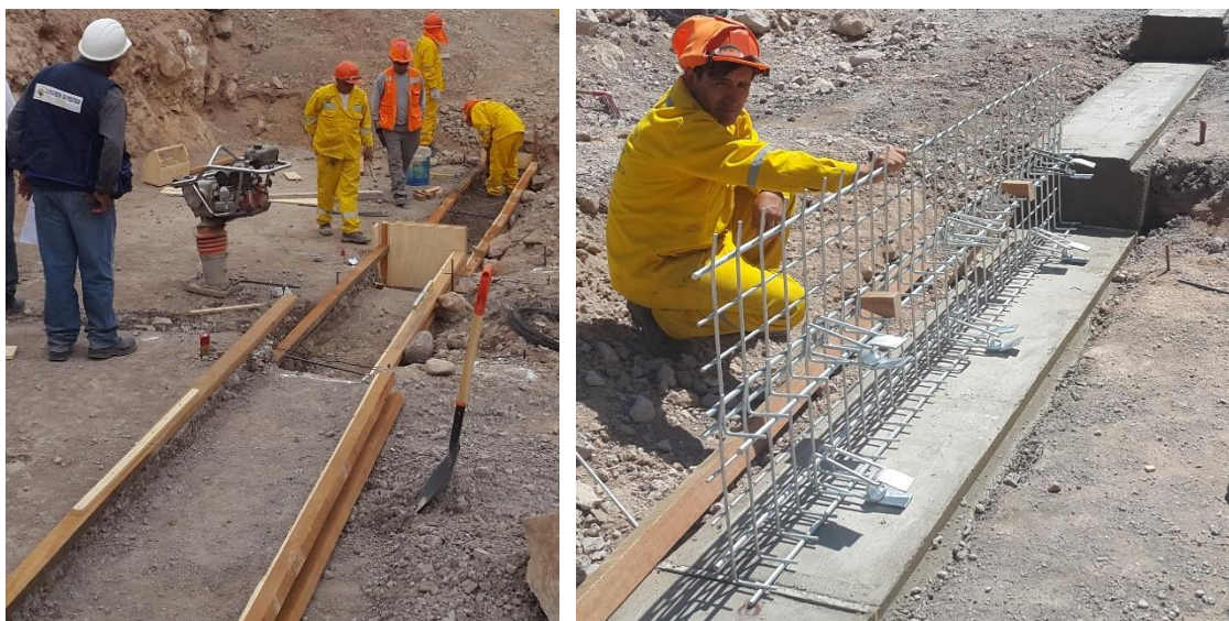
Figuras 4 e 5. Soleira em execução para alinhamento do paramento frontal da contenção. FONTE: Freyssinet Terra Armada Perú S.A.C.
