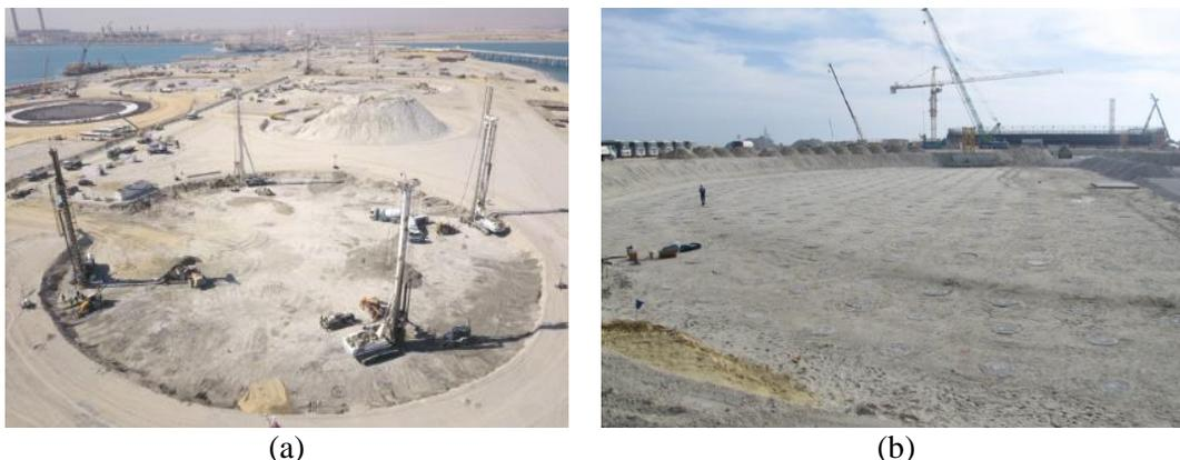
Figura 4. Execução projeto tanques de gás natural (a) Processo de escavação hélice contínua (b) inclusões rígidas finalizadas (Bernuy et al., 2018)
